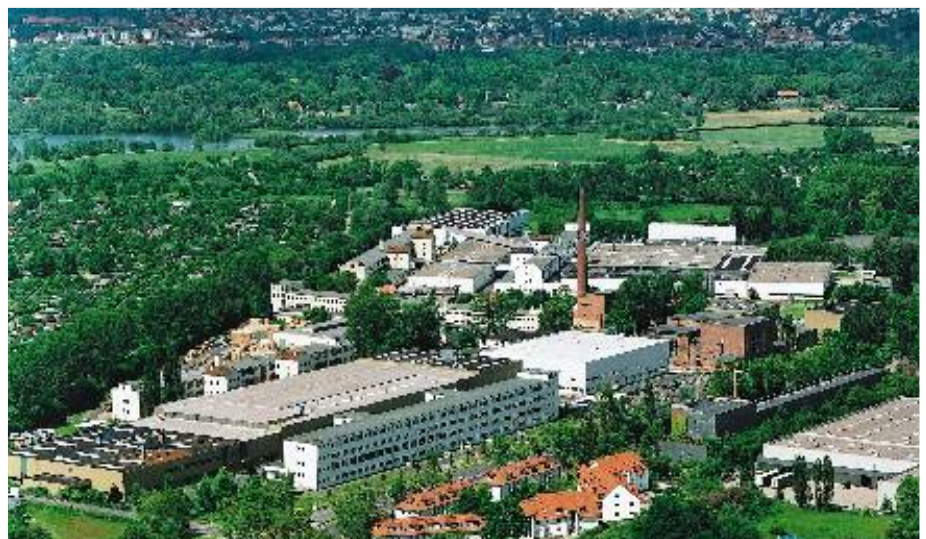
Bureau de vente principal et centre de compétences de Kassel, en Allemagne
