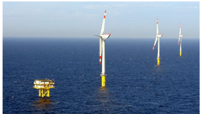
Transformador 75 MVA 115/31 kV com sistema de monitoramento MS3000 para uma planta eólica off-shore da Alpha Ventus, em operação desde 2008
