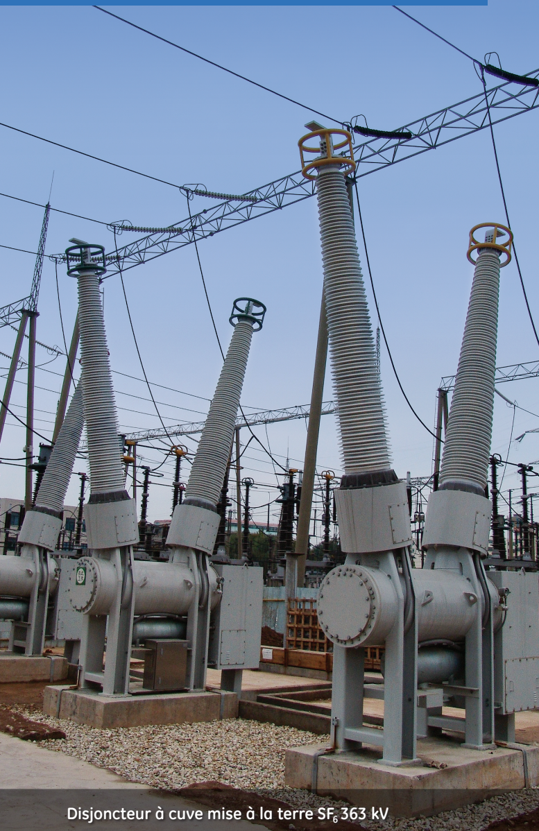
Disjoncteur à cuve mise à la terre SF 6 800 kV
