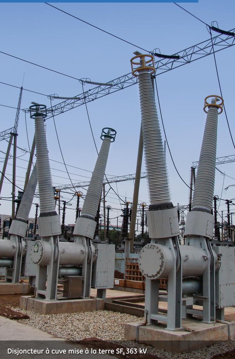
Disjoncteur à cuve mise à la terre SF<sub>6</sub> 363 kV
