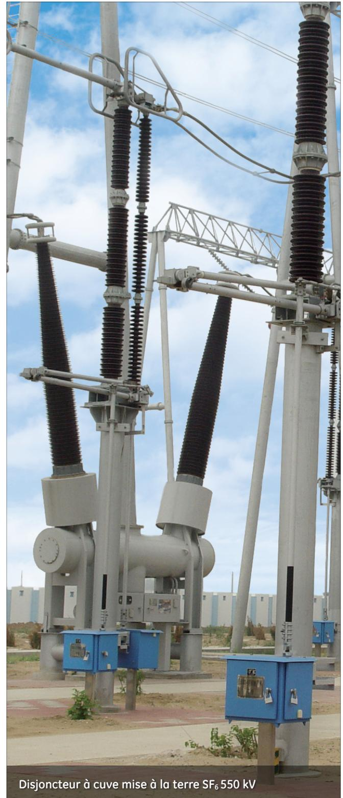
Disjoncteur à cuve mise à la terre SF<sub>6</sub> 550 kV
