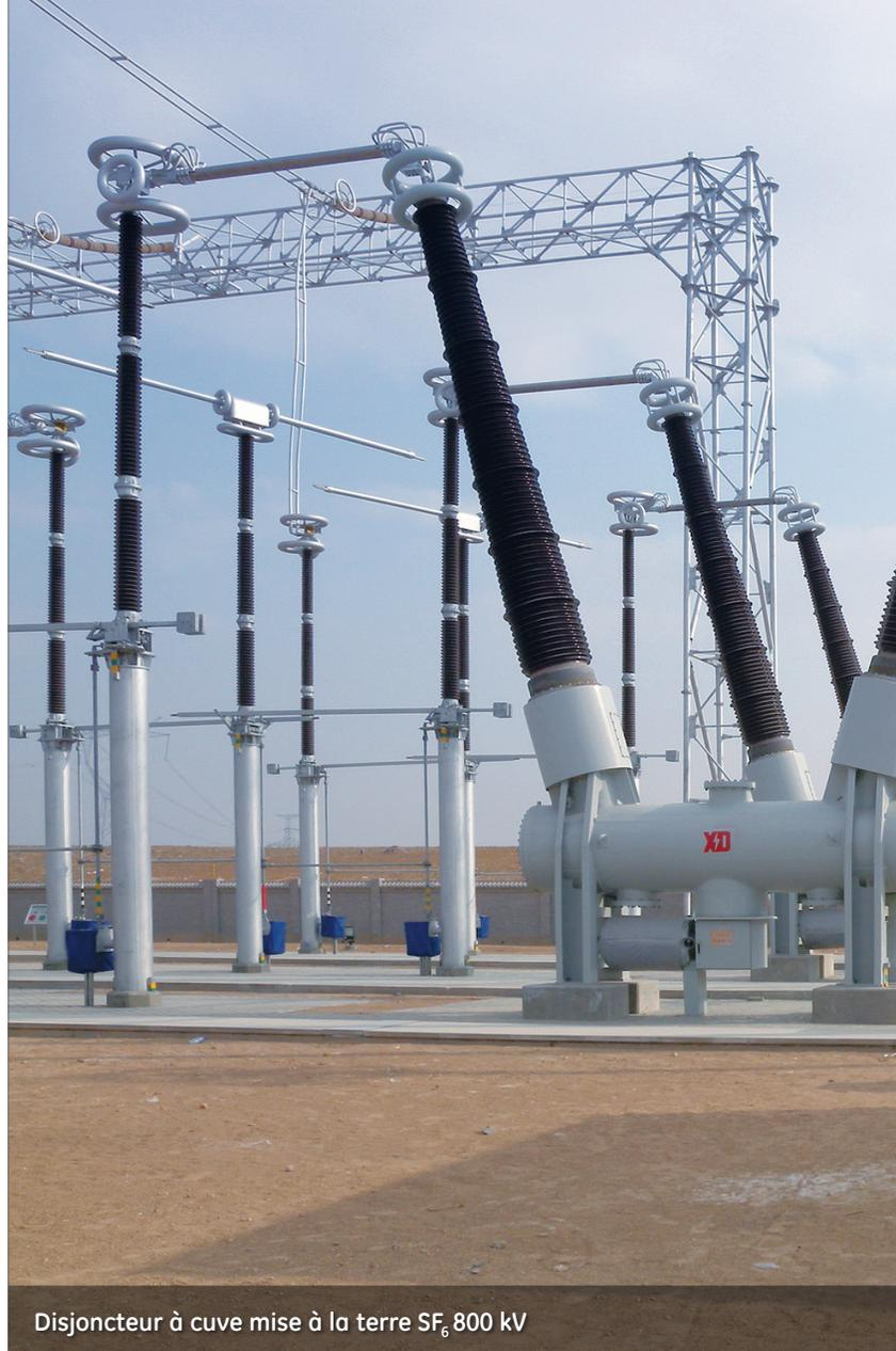
Disjoncteur à cuve mise à la terre SF<sub>6</sub> 800 kV
