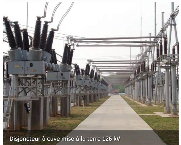
Disjoncteur à cuve mise à la terre 126 kV
